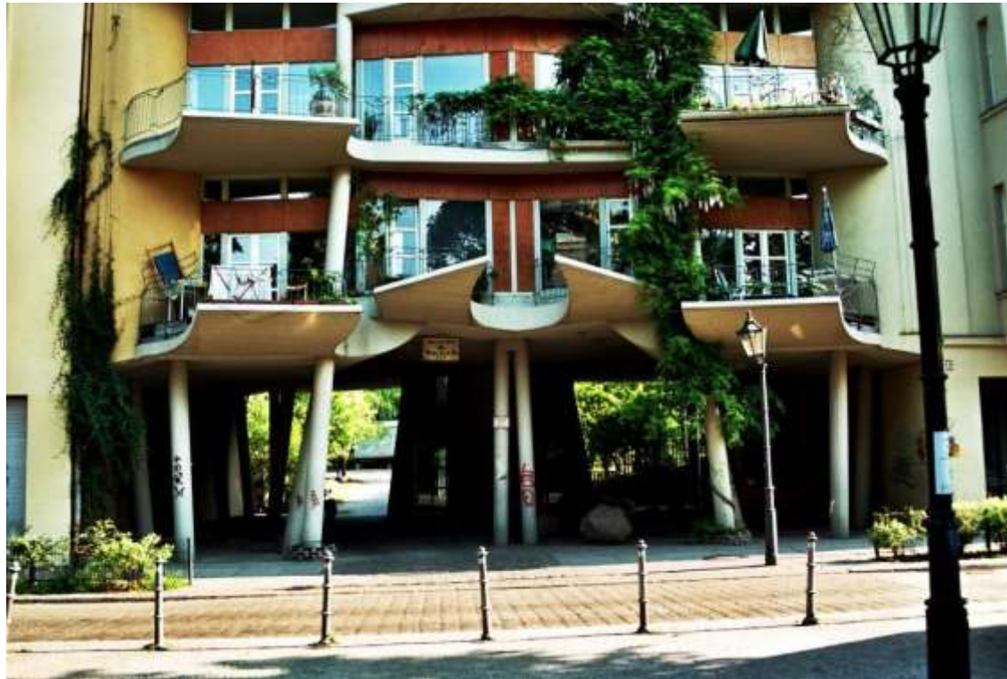
fraenkelufer (architekt: hinrich baller)
